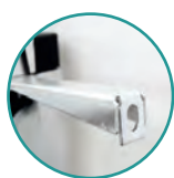
Fissaggio della struttura al muro
